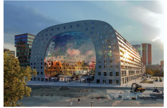
Markthal Rotterdam / MVRDV
